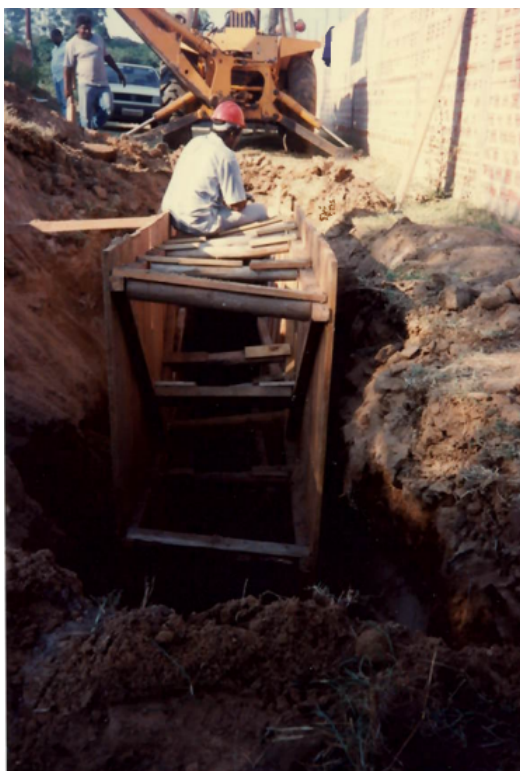
Imagem antiga de servidores utilizando Escoramento improvisado de madeira
